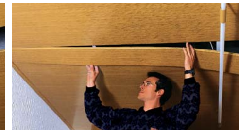
INSTALACIÓN DE FALSO TECHO DE P.V.C. SOBRE PERFIL PRIMARIO CON LAMA REGISTRABLE
