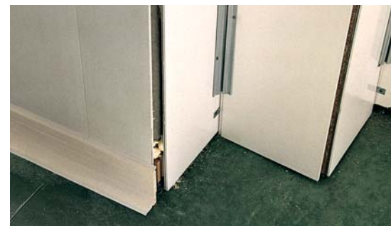
MONTAJE P.V.C. CON PERFIL SANITARIO
