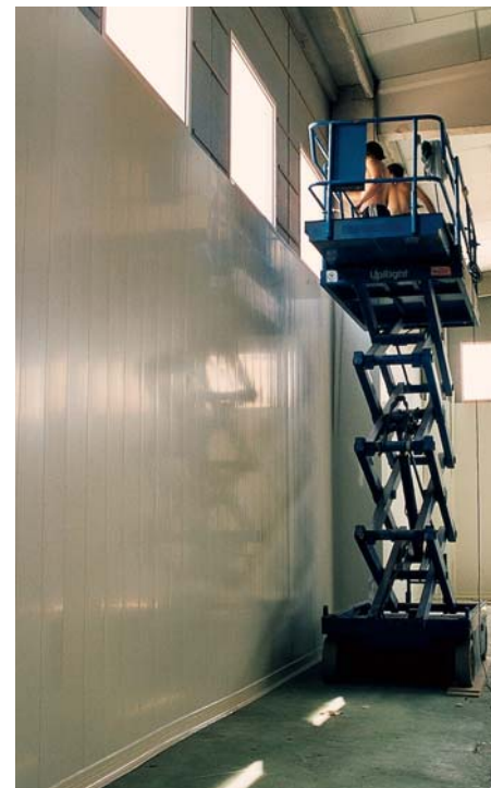
MONTAJE P.V.C. CON PERFIL SANITARIO
