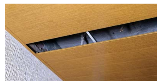
INSTALACIÓN DE FALSO TECHO DE P.V.C. SOBRE PERFIL PRIMARIO CON LAMA REGISTRABLE
